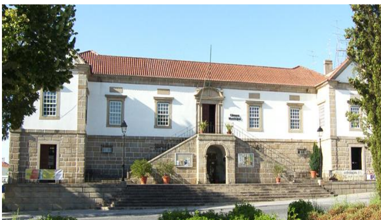
Figura 3: Edifício da Câmara Municipal de Castelo Branco
