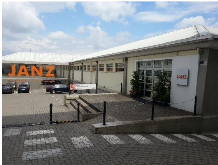
Figura 2: Instalações da Janz - Contadores de Energia, SA
