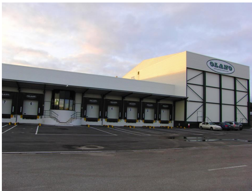
Figura 13 - Parte do Cais e Entrepasto Frigorífico
