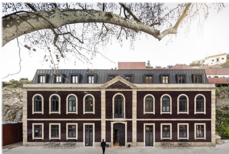
Figura nº 2 - Parte antiga do Longroiva Hotel Rural & Termal SPA já restaurada Fonte: https://goo.gl/images/ziqfFu
