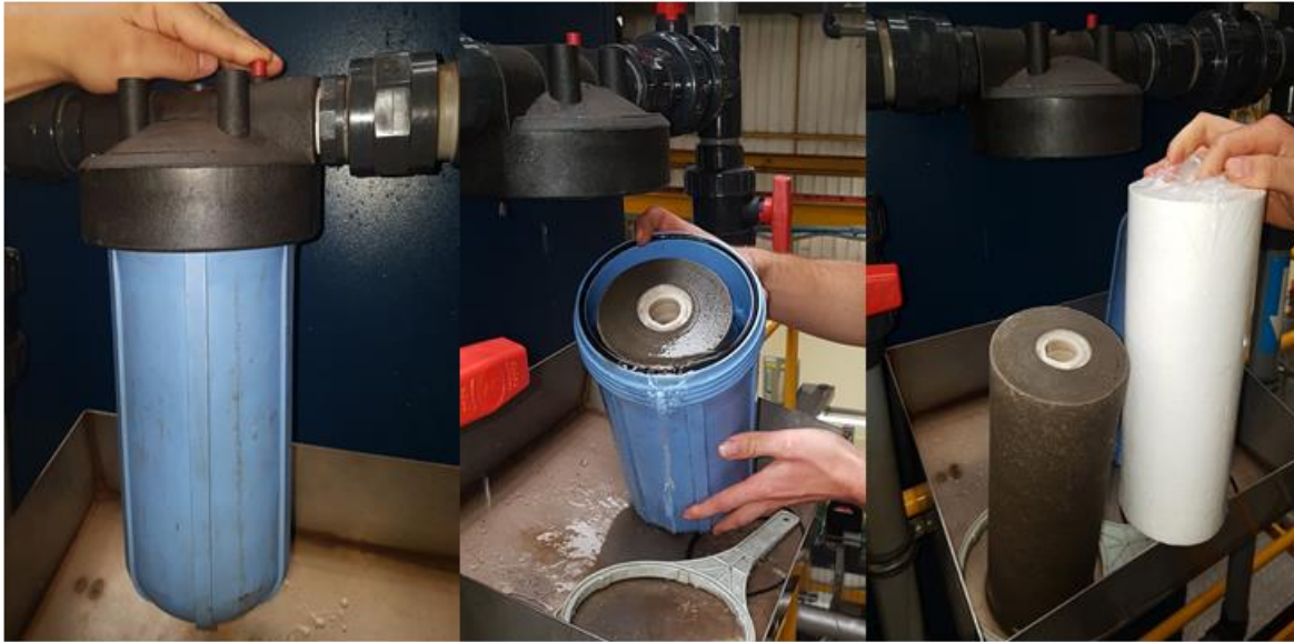
Figura 28 - Purgar, remoção de cúpula e substituição do filtro
