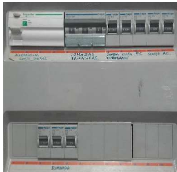
Figura 21 - Quadro parcial do laboratório
