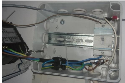
Figura 23: Ligações SR24-contactor. (Fonte: Própria)
