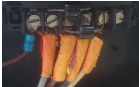
Figura 44: Montagem dos díodos de proteção. (Fonte: Própria)
