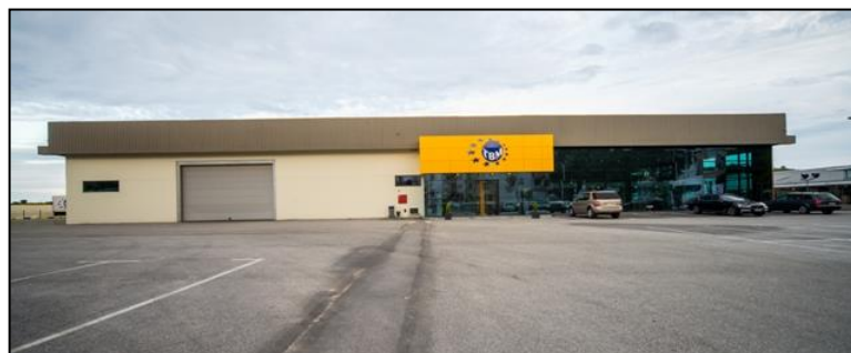
Figura 3 – Novas Instalações da TBM Fonte: Website TBM
