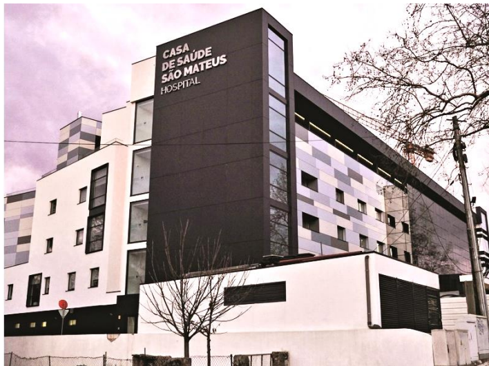
Figura 2 – Instalações Casa de Saúde São Mateus
