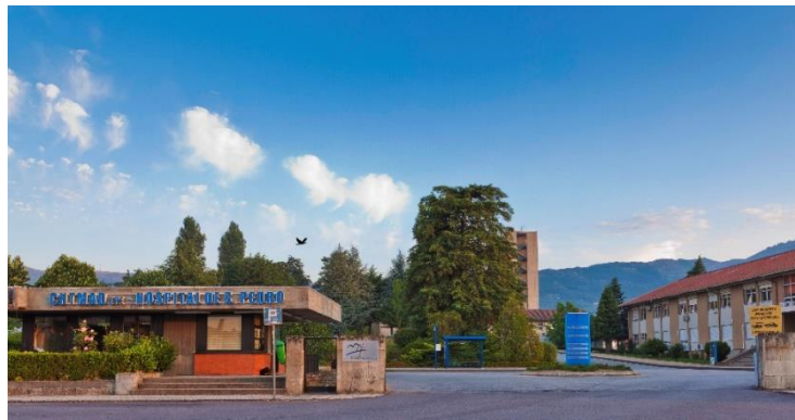
Figura 1: Unidade Hospitalar de Vila Real
