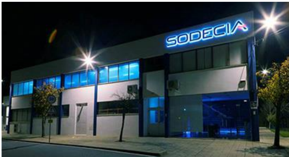
Figura 3- Instalações exteriores da SODECIA da Guarda
