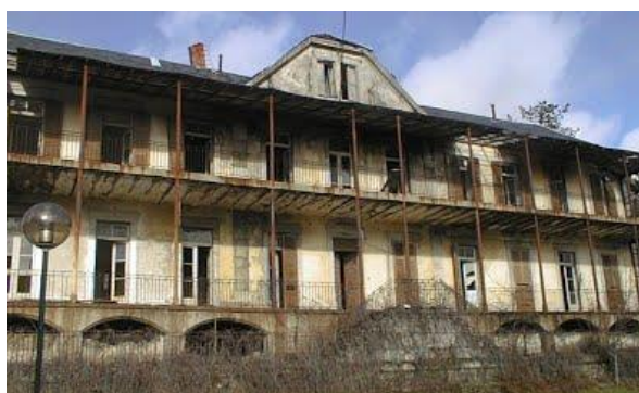
Figura 3: Um dos edifícios do Antigo Sanatório Sousa Martins
