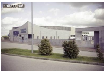
Fig. N° 1 - Parque Privado do Complexo das piscinas
