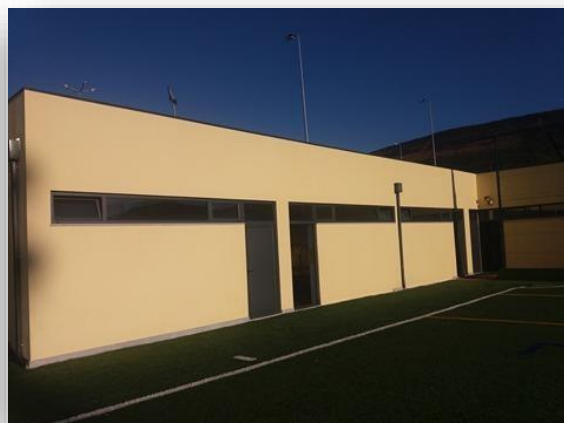
Fig. 8 – Acesso aos balneários.
