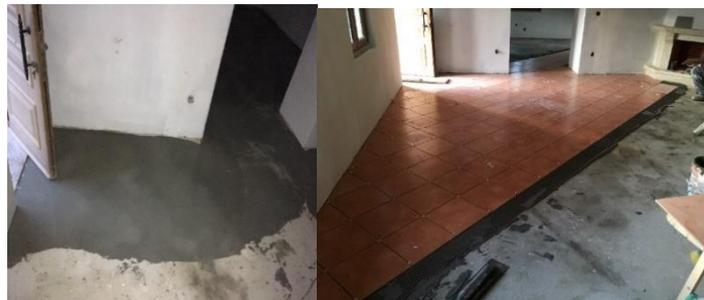
*Figura 45: Camada de regularização e assentamento de pavimento cerâmico na sala*
