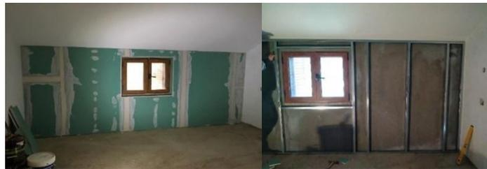
*Figura 53: Aplicação de gesso cartonado hidrófugo na cozinha*
