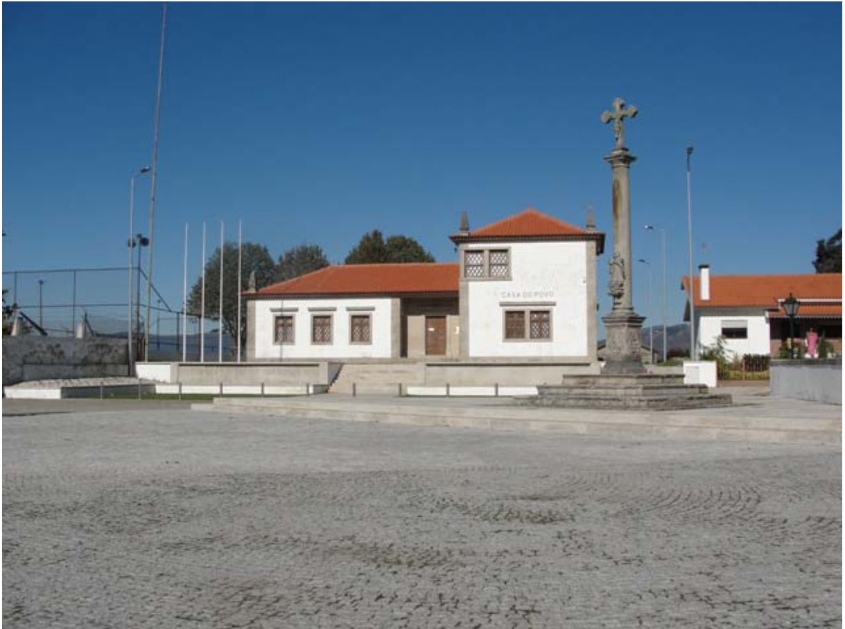
Figura n.º2 – Sede da ACRVF (antiga Casa do Povo)
