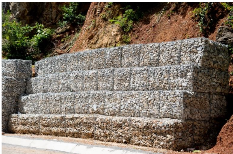
Imagem 10: contenção dos taludes (Fonte: Escolaengenharia)
