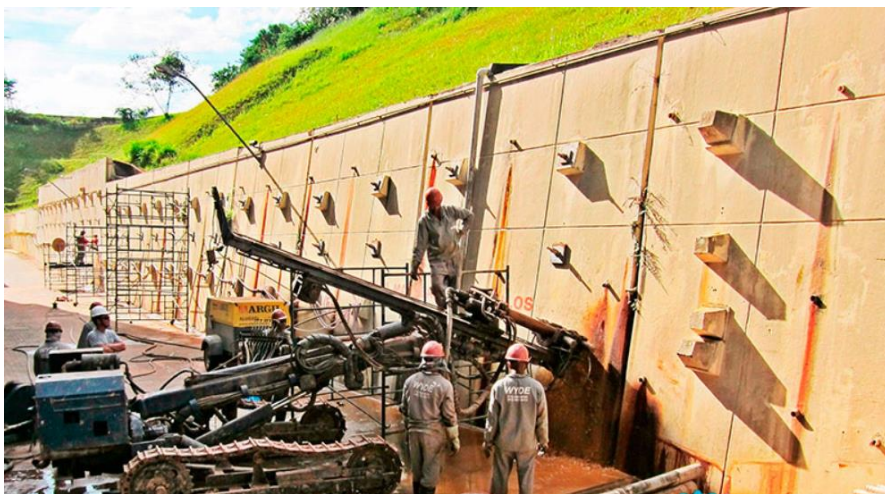
Imagem 9: contenção dos taludes (Fonte: www.Wyde.com )
