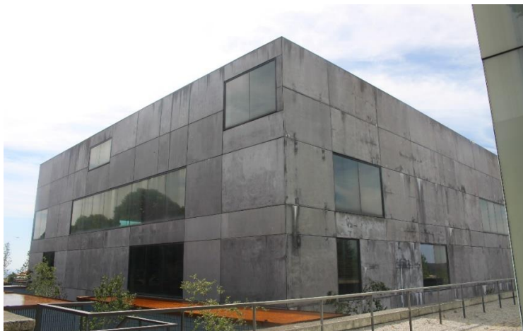
Figura 2- Edifício do TMG
