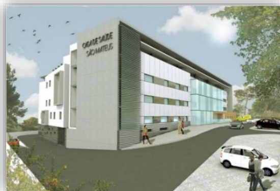
Figura 3-Novas instalações Casa de Saúde São Mateus, S.A-Hospital
