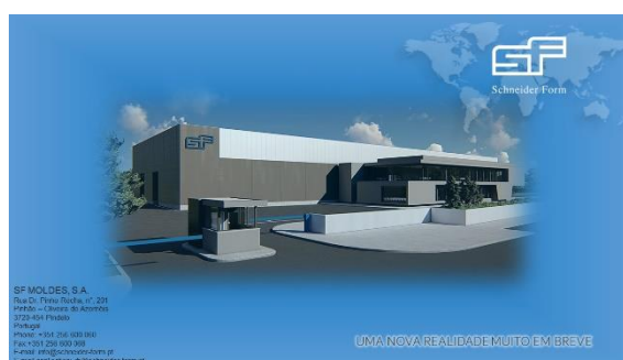
Figura 9. Anúncio Institucional das novas instalações da SF MOLDES SA
