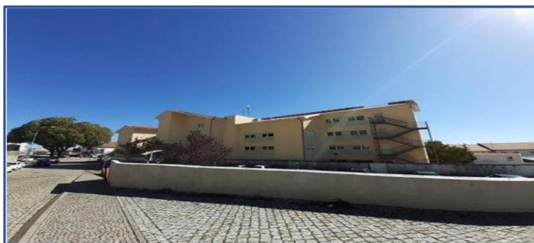
Figura 2- Edifício da ERPI
