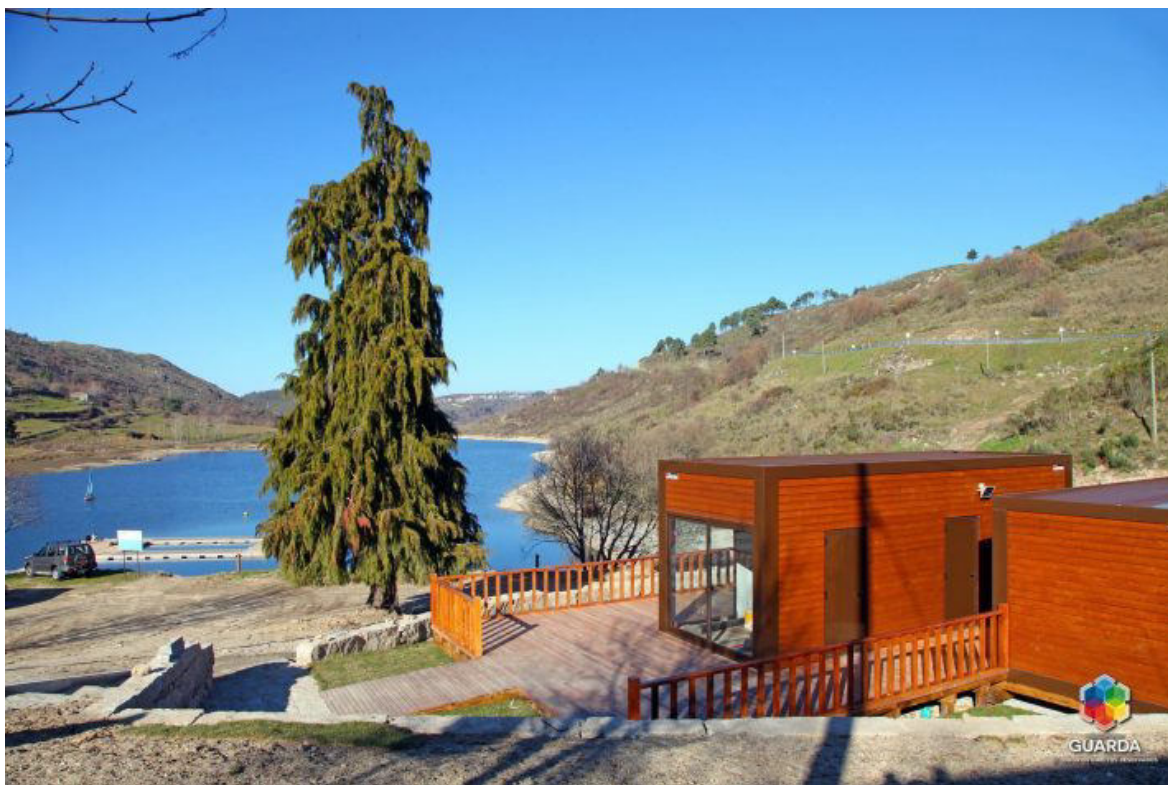
Figura 27- Aspeto das instalações inauguradas na Barragem do Caldeirão
