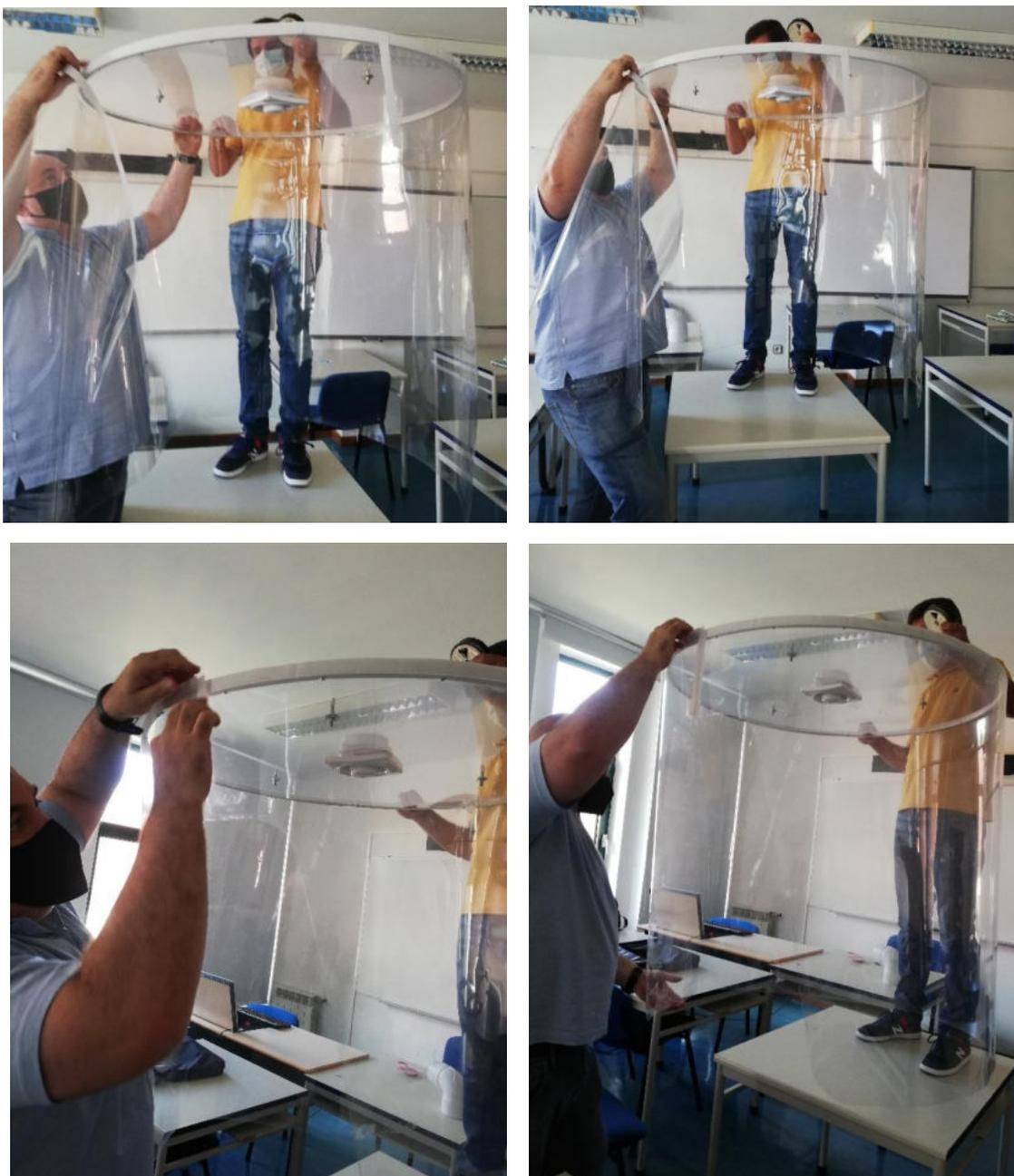
Fig. 94 – Aplicação do fio de pesca e da cobertura plástica
