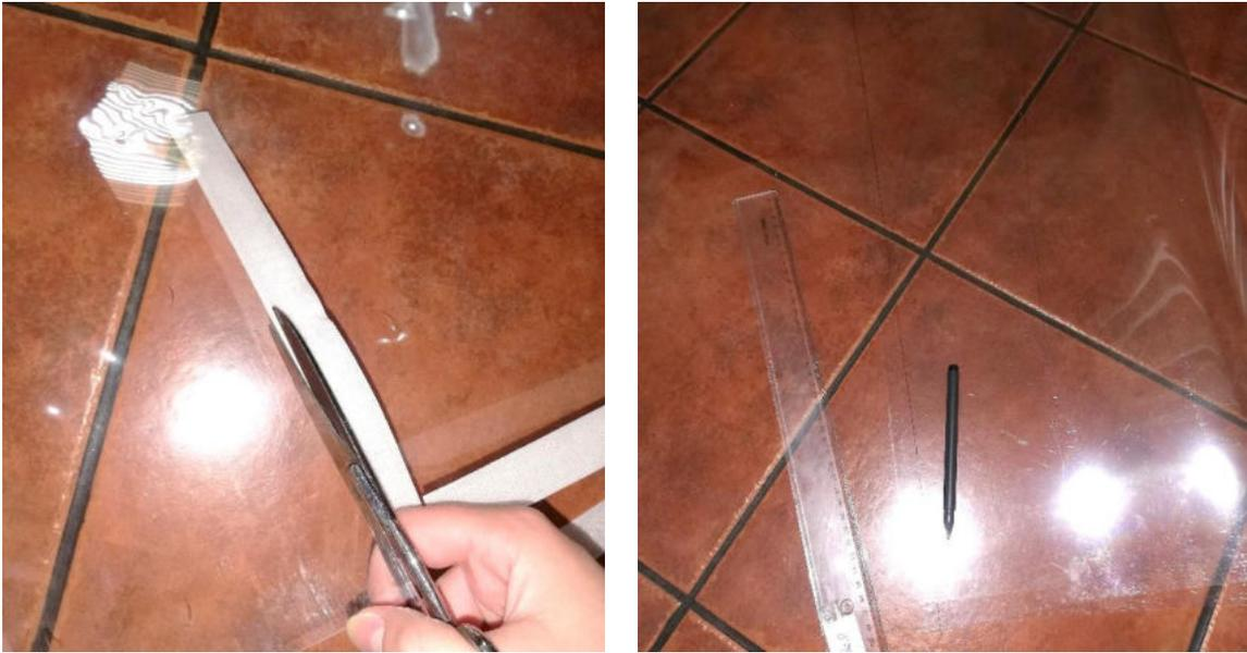
Fig. 92 – Colocação da fita velcro e recorte da abertura na película de PVC
