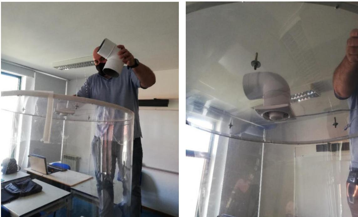
Fig. 96 – Aplicação da curva de PVC e da instalação da tomada do extrator
