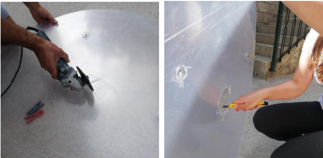
Fig. 85 – Corte do orifício central e acabamentos
