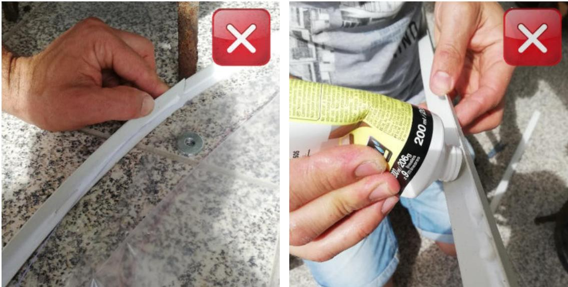
Fig. 86 – Aplicação do aro á estrutura acrílica por meio de cola acrílica
