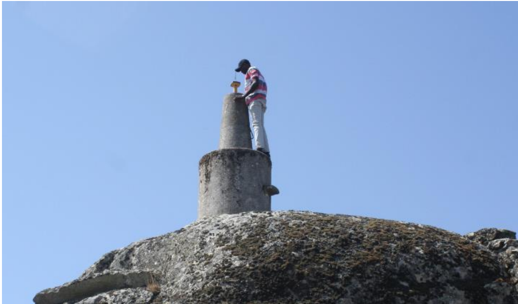
Figura 40- Colocação da base no vértice geodésico Vigia.
