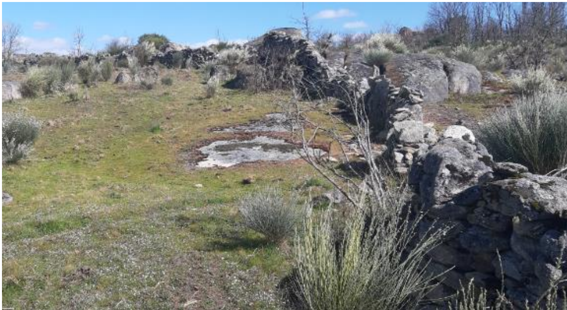
Figura 47- Muro que contorna o limite da pedreira.
