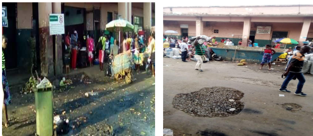
Figura 7. Frontaria (imagem da direita) e traseira (imagem da esquerda) do Mercado Municipal de Água - Grande, cidade de São Tomé Fonte: (Carvalho, 2019).
