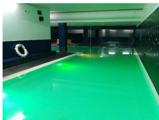
Figura 9. Piscina. Fonte própria.
