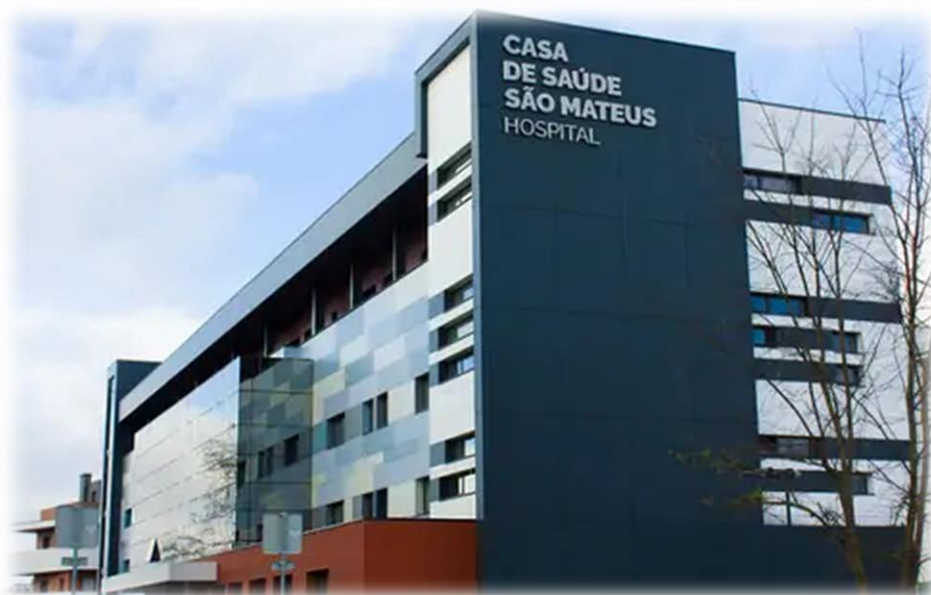
Figura 1- Instalações Externas do Hospital Casa de Saúde S. Mateus
