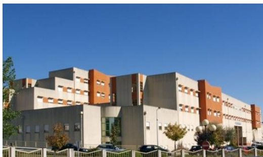
Figura 1 - Hospital Pêro da Covilhã [3].
