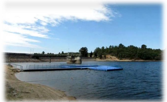
Figura 31- Piscina da Barragem da Capinha
