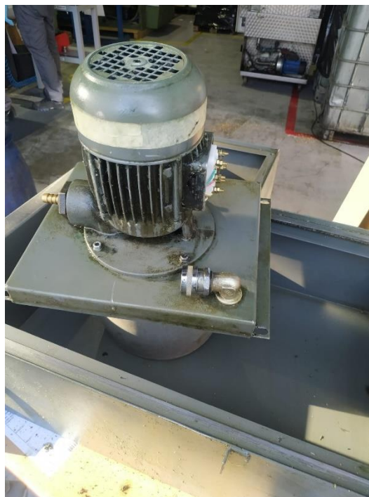
Figura 32- Tanque limpo e limpeza do exterior do motor
