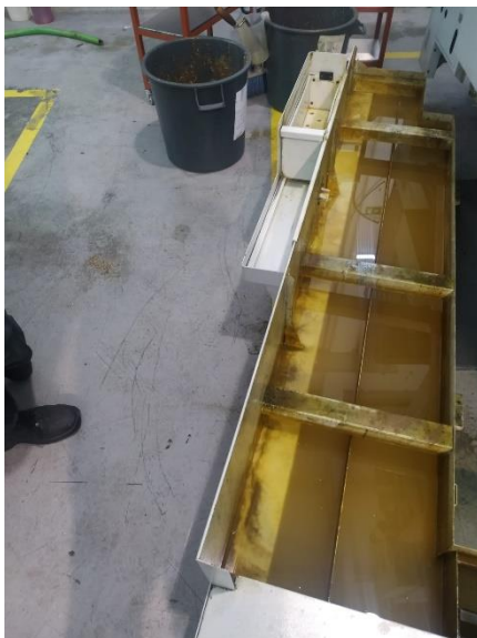
Figura 37- Tanque limpo e com óleo novo
