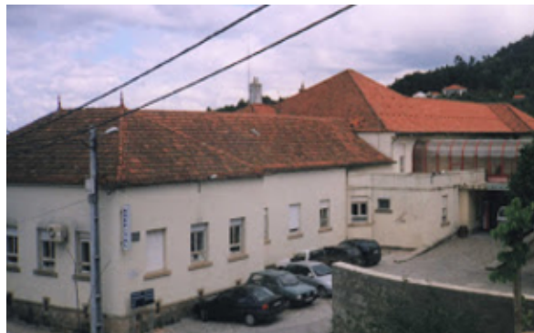
Figura 4 - Hospital antes da remodelação
