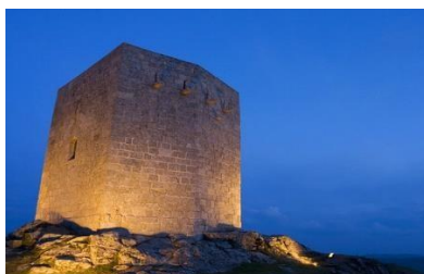
Figura 7 - Torre de Menagem
