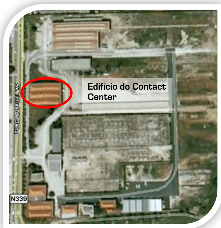
Figura 6 – Vista aérea da localização do Contact Center
