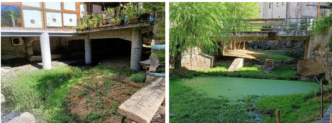
Figura 15- Passagens hidráulicas em Sameiro
