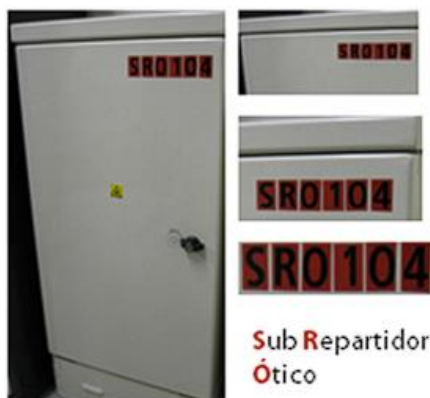
Figura 12 - Sub-repartidor ótico (Altice, SA, 2021)
