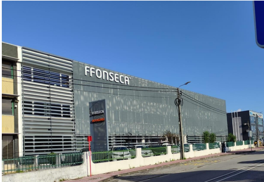
Figura 3- Exterior das Instalações da empresa F.Fonseca S.A.
