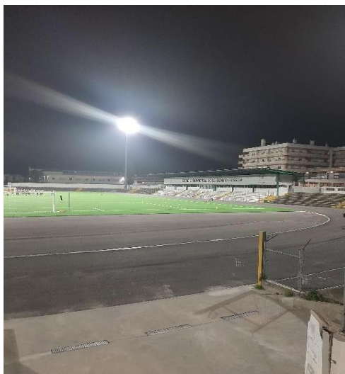
Figura 26- Bancadas do estádio. Fonte: Própria
