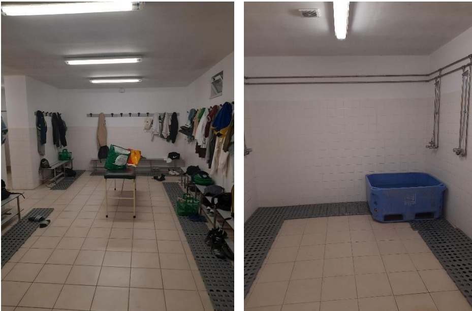
Figura 28- Balneário do estádio Fonte: Própria
