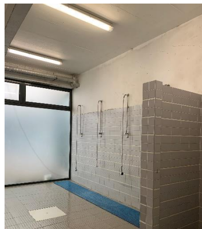
Figura 8- Zona dos chuveiros (fonte própria)
