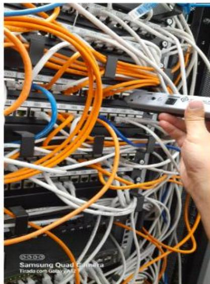
Figura 10 - Testagem da conectividade de portas.
