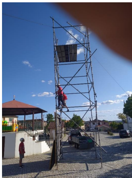
Figura 22- Montagem da parede de escalada
