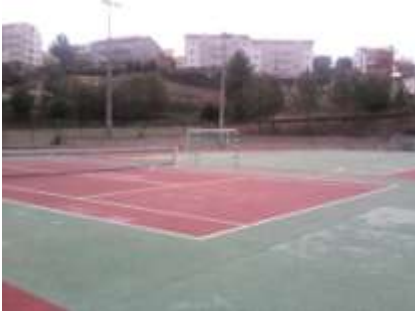
Figura 9 - Campo polidesportivo exterior
