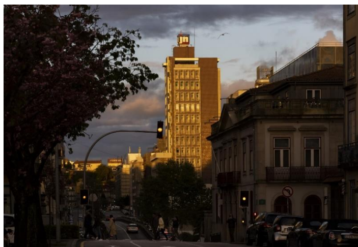
Figura 5 - Edifício na Rua Gonçalo Cristóvão
