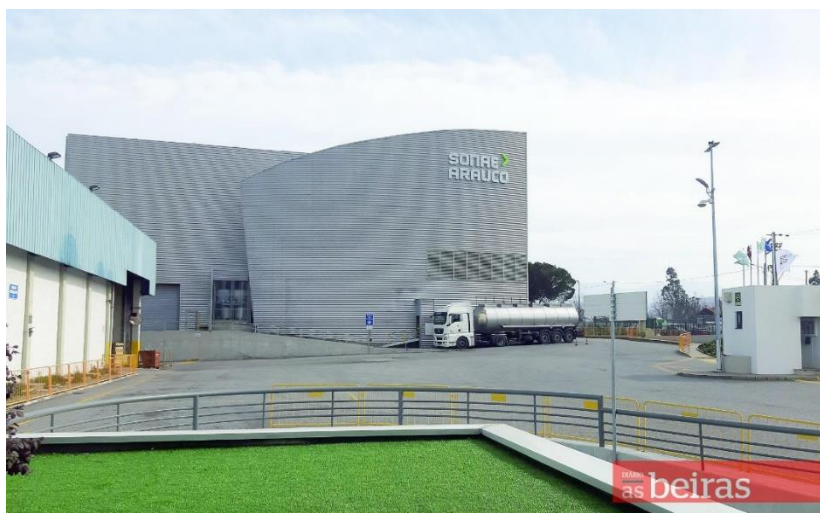
Figura 2- Empresa Sonae Arauco- Oliveira do Hospital Fonte: https://www.asbeiras.pt
