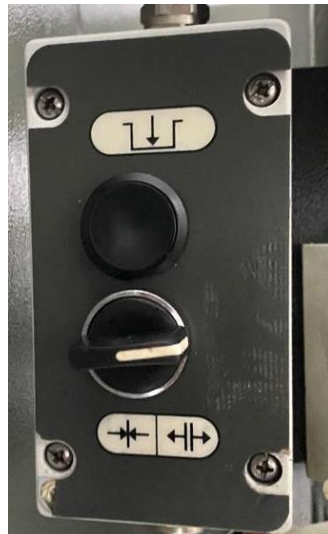
Figura 33 - Acionamento das morsas e de desbloqueio da ferramenta do mandril
