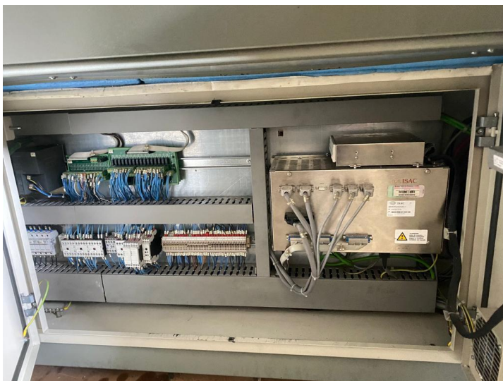
Figura 71 - Conclusão da limpeza do quadro elétrico
