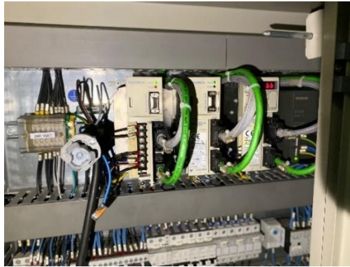
Figura 14 - Drivers com sistema de comunicação com cabos RS232
