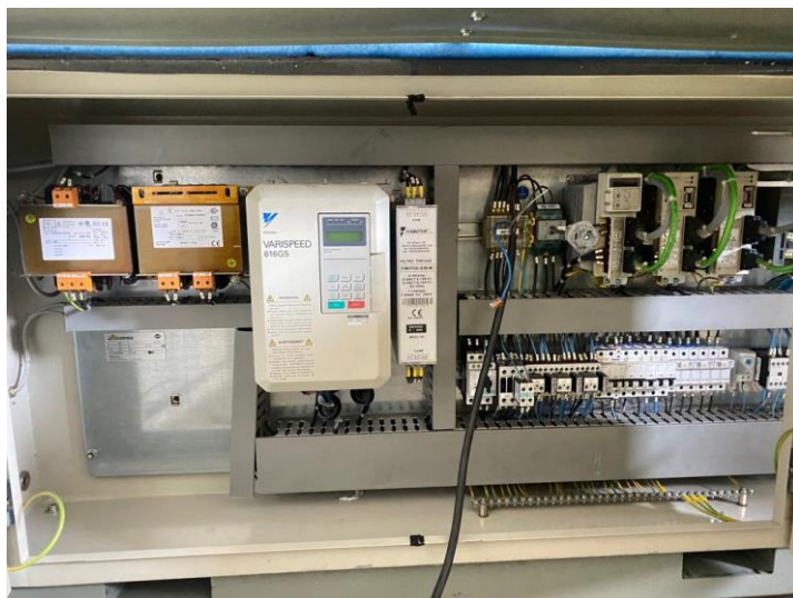
Figura 70 - Arranjo do interruptor e limpeza do quadro
