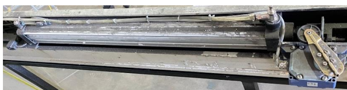
Figura 54 - Cilindro pneumático danificado
