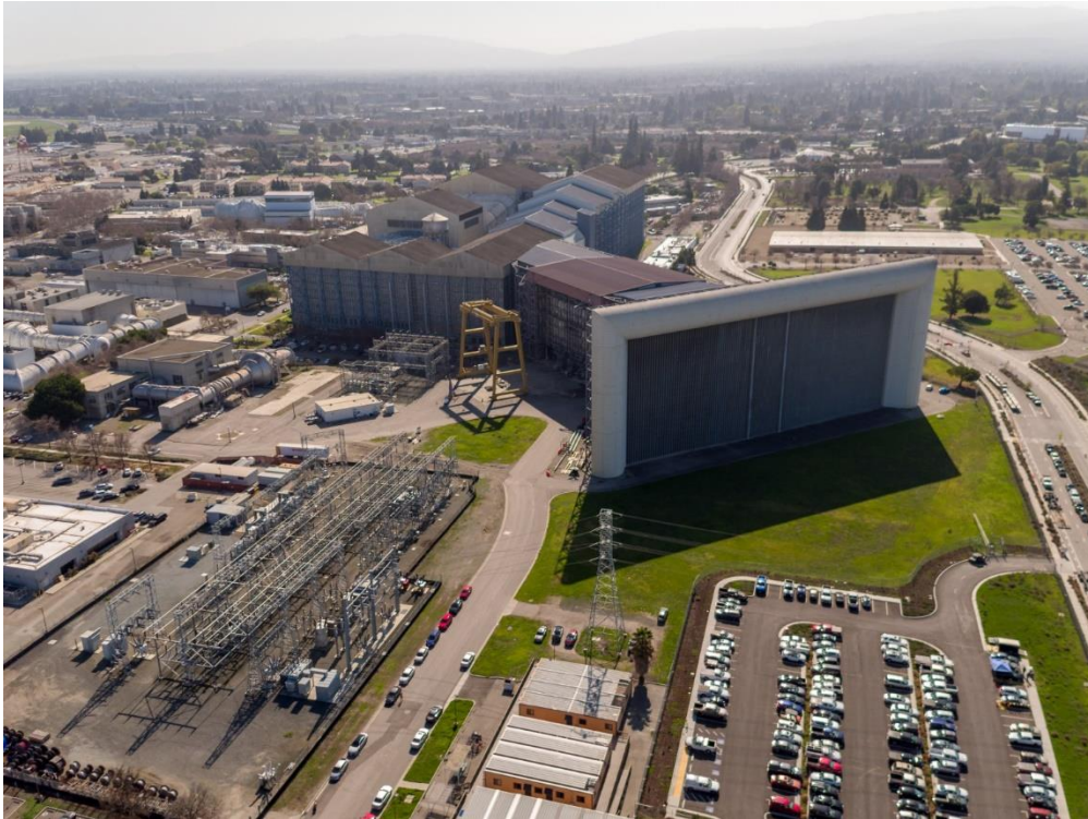
Figura 4: Túnel de vento da Ames Research Center, com uma dimensão de 25m largura e 35m altura, equivalente a um prédio de 13 andares [16]
