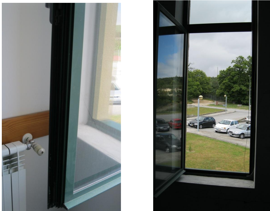
Figura 17- Janela com vedante em todo o seu perímetro
