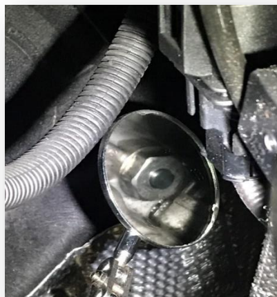
Figura 19 - Estado da corrente de distribuição
