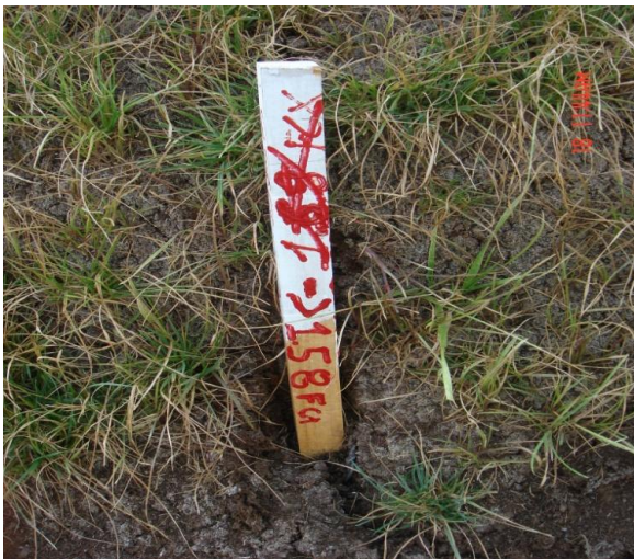
Ilustração 21 – Estacas com sinalização, para Escavação
