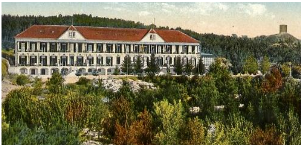
Figura 1 – Sede da Unidade Local de Saúde da Guarda, E.P.E
