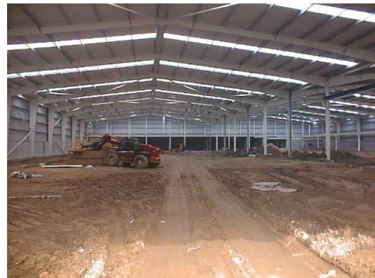
Instalação das estruturas metálicas, telhado e execução das paredes laterais em tijolo.
